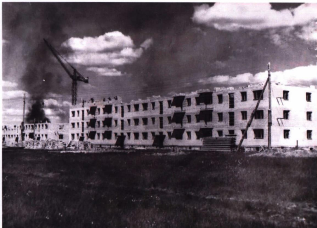
1963 год, строительство домов №№ 4,6 на будущей ул. Менделеева
