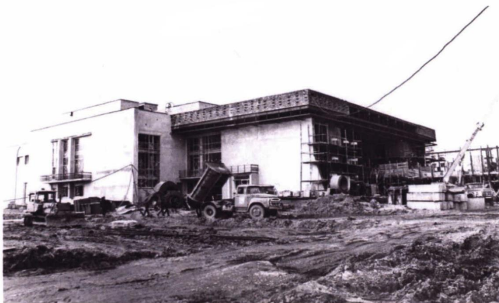
Строительство Дворца культуры химиков, 80-е гг.
